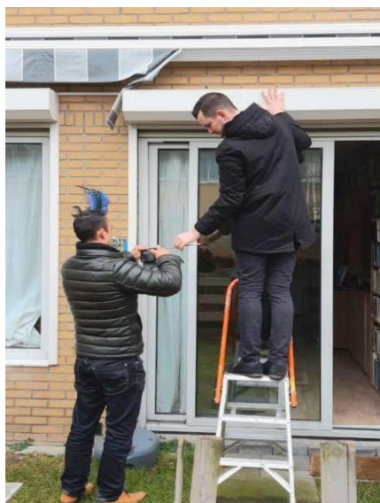
Isolatie checken met de breinaald
